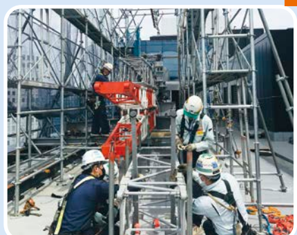
OJS-50Nの組立用にOJ-13Nを組立。 組立揚重機がないため、 組立用の足場を設置。
