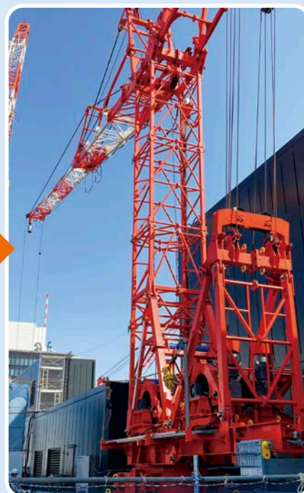
組立終了後、検査用ウエイトにて 荷重試験を実施。最終点検終了後、 点検表と合わせてお引き渡し。
