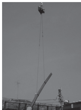
<鉄筋 地下投入>
